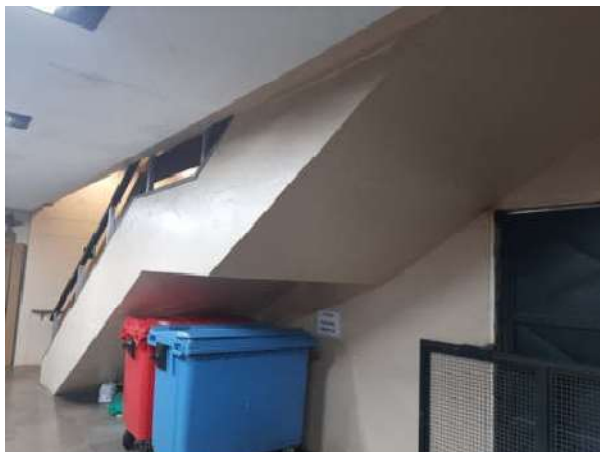
Imagem 2 - Parede circundante área enclausurada
