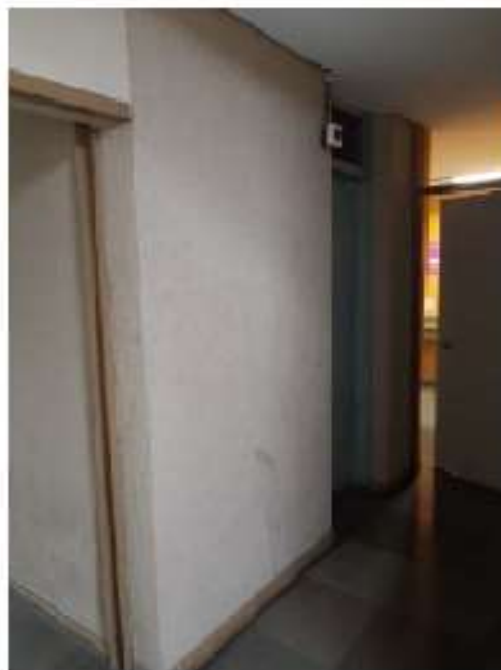
Imagem 9 - Parede central acesso sanitário
