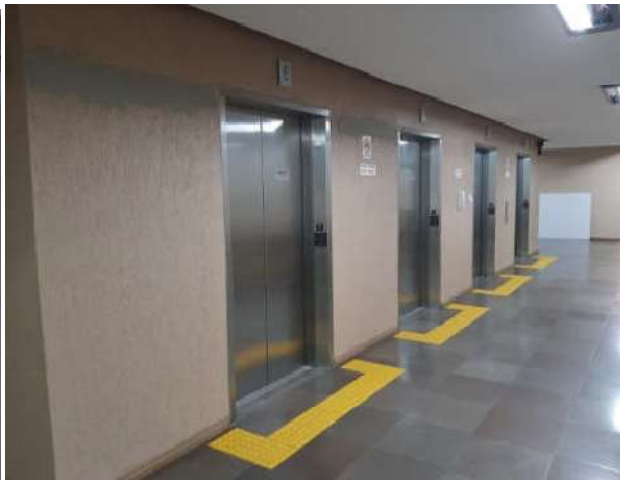
Imagem 7 - Parede central Ala Sul 1º Pavimento
